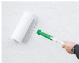
Unterputz mit **WP-QUARZ** grundieren. Der hochwertige Putzgrund sorgt für eine optimale Haftung und ein gleichmäßiges Auftrocknen des nachfolgenden Putzauftrages. Fassade nach dem Grundieren erneut gut durchtrocknen lassen.
